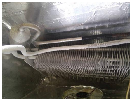
ภาพที่ 12 ภายในห้องควบคุม
