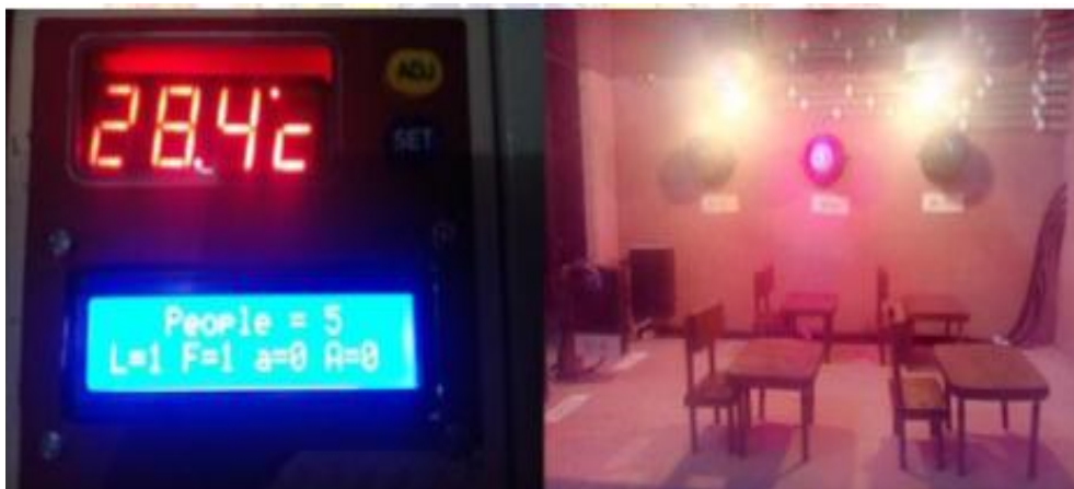
ภาพที่ 7 แสดงการทำงานของหลอดไฟและพัดลมเมื่อมีคนเข้ามาในห้อง 1-5 คน และอุณหภูมิสูงกว่า 25 องศาเซลเซียส
