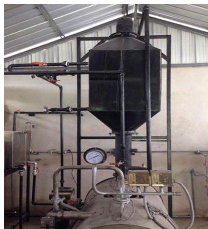
ภาพที่ 2 ลักษณะติดตั้งชุดอีโคโนไมเซอร์
