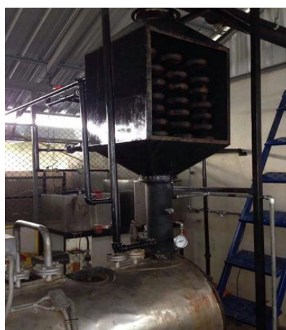
ภาพที่ 3 ท่อชุดอีโคโนไมเซอร์
