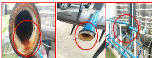
Figure 4 ความสัมพันธ์ระหว่างการตรวจเช็คท่อน้ำประปาพบ คราบสนิมภายในท่อด้านดูดของปั๊มและที่ถังน้ำ
