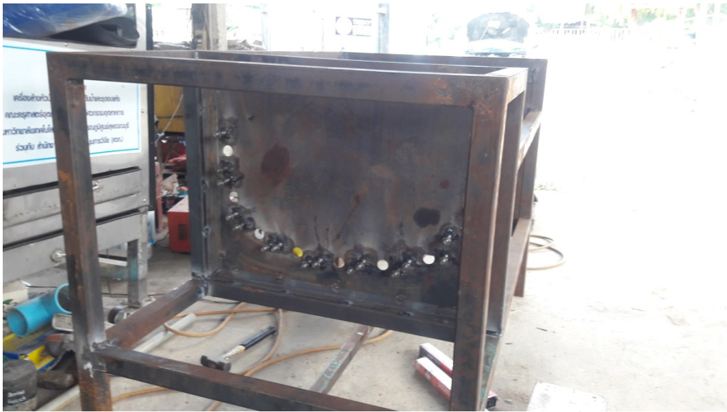
ภาพการขึ้นโครงสร้างเครื่องจักร
