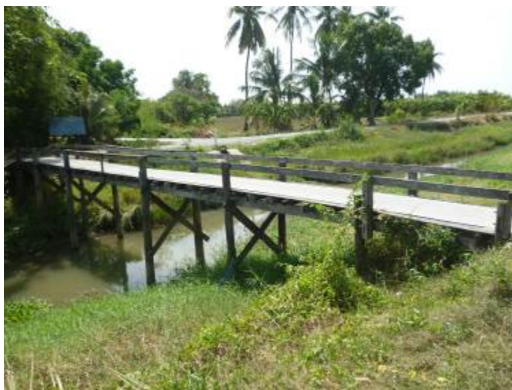
ภาพที่ 2 สะพานข้ามคลองตาลเสียน เชื่อมต่อระหว่างพื้นที่หมู่ 4 และหมู่ 3
