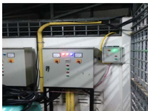
รูปภาพที่ 4.12 ภาพการติดตั้งระบบเครื่องสูบน้ำด้วยเทคโนโลยี Internet of Things
