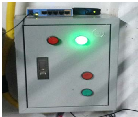
รูปภาพที่ 4.13 ภาพการติดตั้งระบบเครื่องสูบน้ำด้วยเทคโนโลยี Internet of Things ที่เสร็จสมบูรณ์
