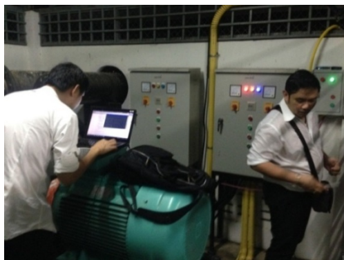
รูปภาพที่ 4.12 ภาพการติดตั้งระบบเครื่องสูบน้ำด้วยเทคโนโลยี Internet of Things
