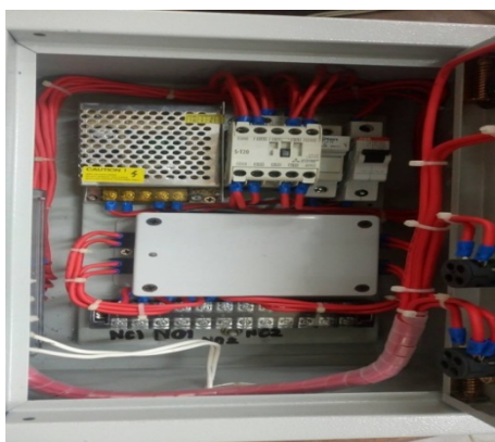
รูปภาพที่ 4.13 ภาพการติดตั้งระบบเครื่องสูบน้ำด้วยเทคโนโลยี Internet of Things ที่เสร็จสมบูรณ์
